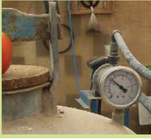
شكل 11: مراقبة مقياس الضغط قبل وبعد المصفيات
