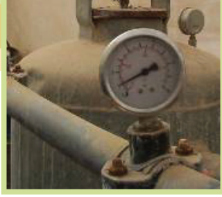
شكل 11: مراقبة مقياس الضغط قبل وبعد المصفيات
